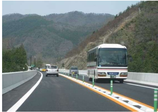
▲ 広域圏を結ぶ尾道松江線
