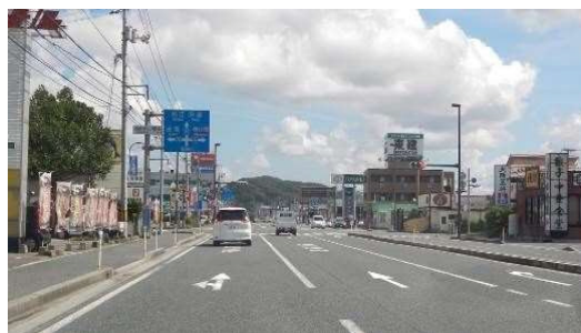
▲ 沿線土地利用が進む国道54号
