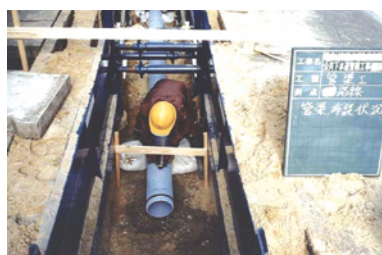
下水管布設工事
