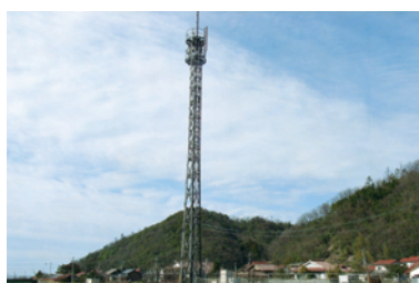
携帯電話用鉄塔
