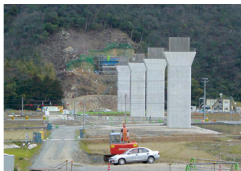
仁摩温泉津道路(福波第2高架橋)
