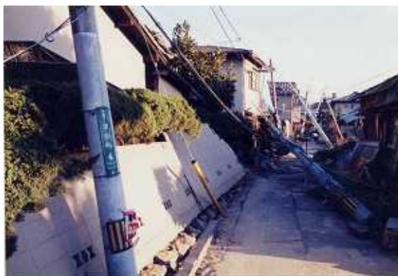
図 3-3 阪神淡路大震災における転倒被害状況
