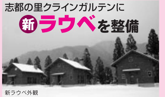
新ラウベ外観
