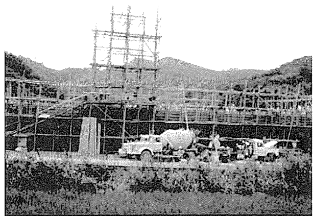
庁舎建設中(1971年撮影)
