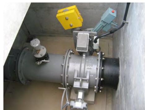
写真 26 緊急遮断弁
