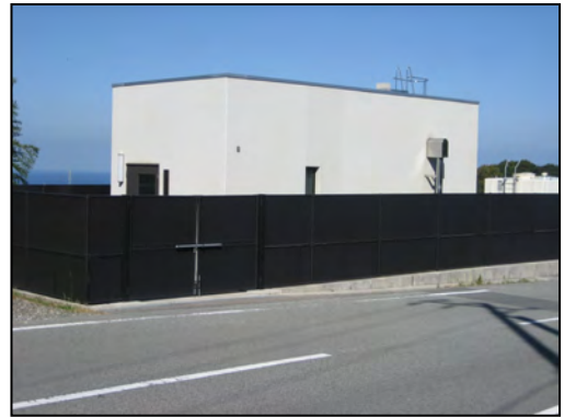
写真 21 三階第 1 ポンプ場
