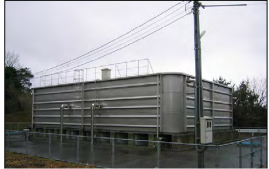
写真 11 原井第1配水池 V=500 \text{ m}^3
