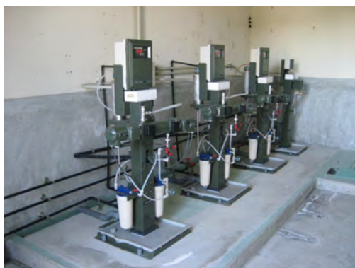
写真 4 水質監視設備
