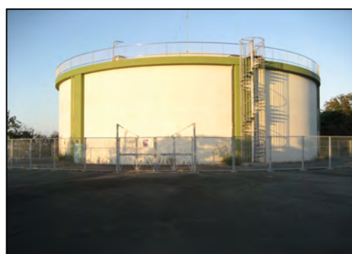
写真 16 生湯配水池 V=3,000 \text{ m}^3
