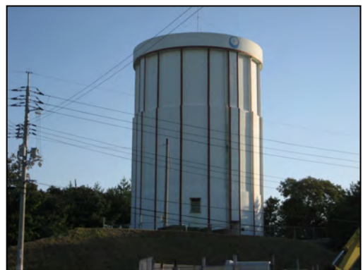
写真 13 石中央地配水池 V=500 \text{ m}^3
