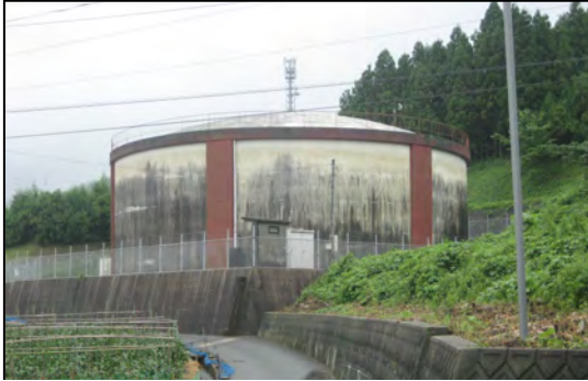
写真 10 石原配水池 V=4,500 \text{ m}^3
