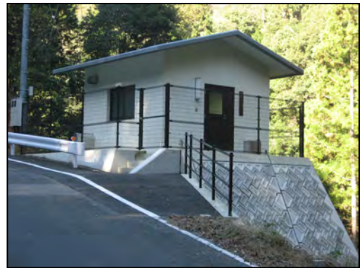
写真 23 田橋第 1 ポンプ場
