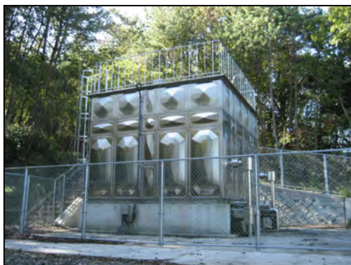
写真 20 十文字原配水池 V=67.5 m 3
