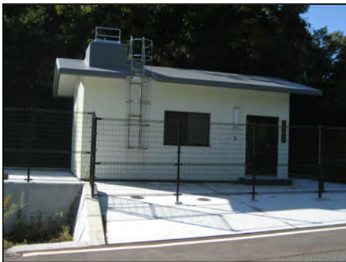
写真 24 田橋第 2 ポンプ場
