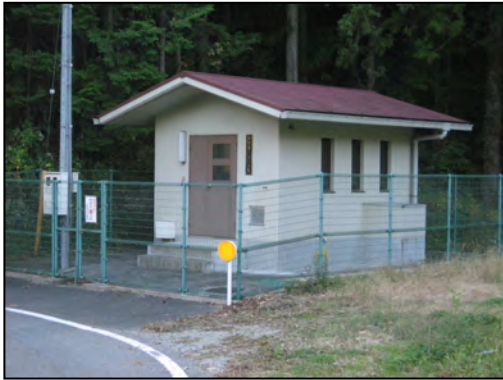
写真 17 後野第 2 ポンプ場
