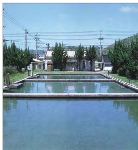
写真 2 旧緩速ろ過池
