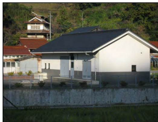
写真 7 国府水源地 平成 12 年建設
