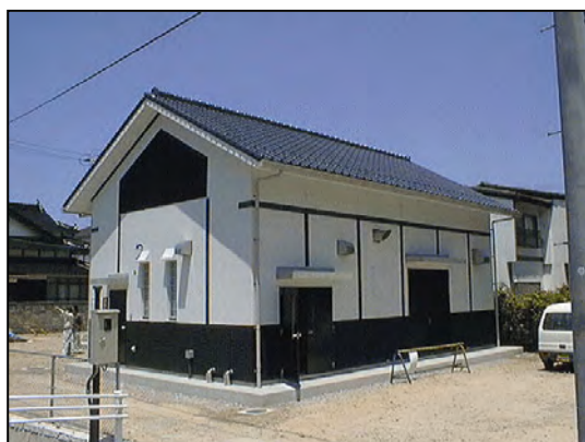
写真 6 黒川水源地 平成 9 年建設
