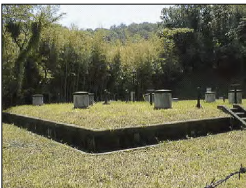
写真 12 相生配水池 V=960 \text{ m}^3
