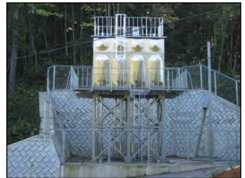
写真 19 長見減圧水槽 V=20 m 3
