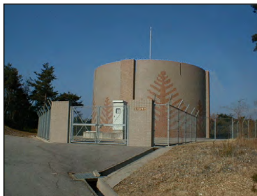
写真 15 上府配水池 V=500 \text{ m}^3
