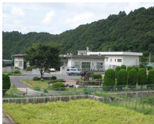
写真 3 美川浄水場 昭和 45 年建設
