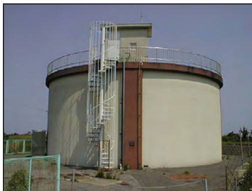
写真 14 国府配水池 V=1,000 \text{ m}^3
