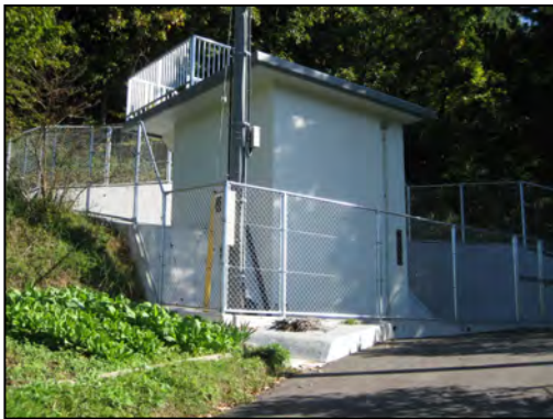
写真 22 田橋第 1 減圧水槽 V=49.2 m 3
