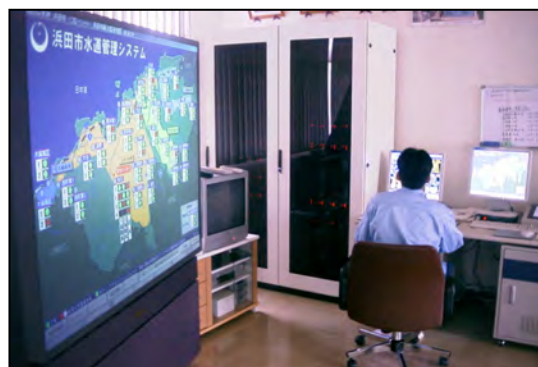
写真 8 遠隔集中監視システム
