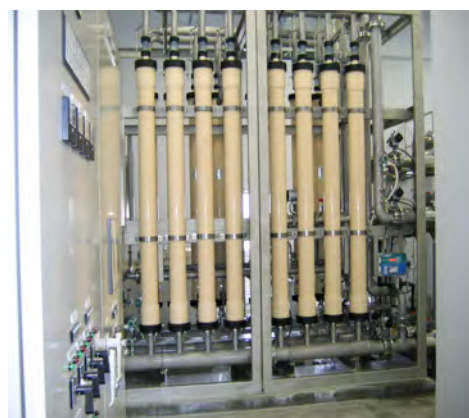
写真 25 膜ろ過装置
