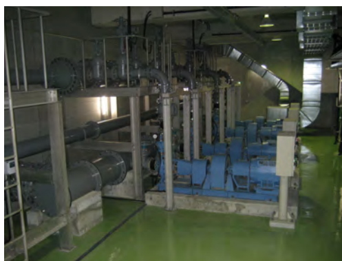
写真 5 送水ポンプ 160kw
