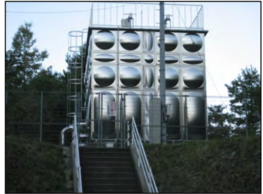
写真 18 後野減圧水槽 V=128 m 3
