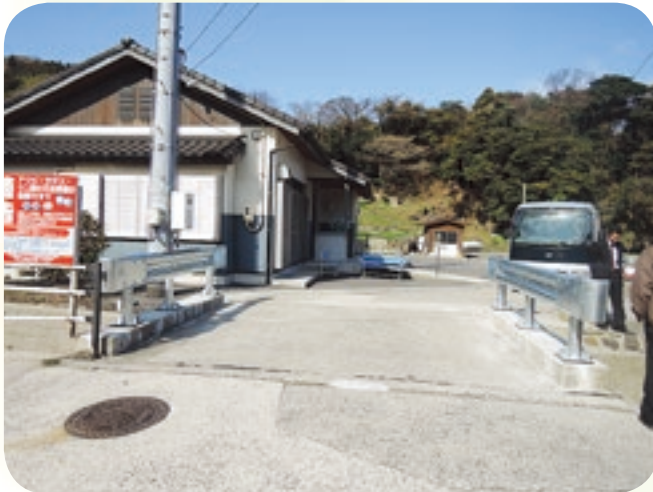
古海集会所横の橋
