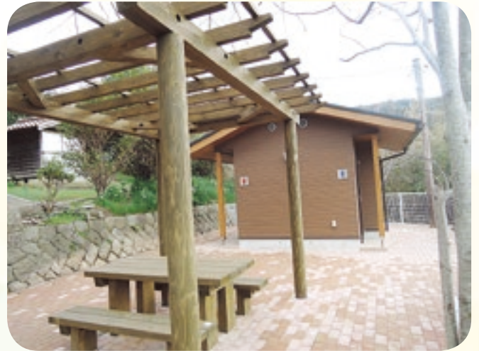
一宮神社に公衆トイレが完成しました
