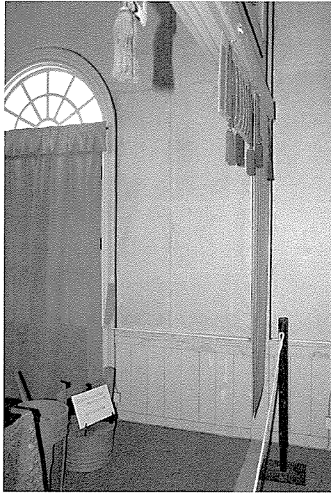
写真1 貴顕室の南側の壁（今回調査した部分）
