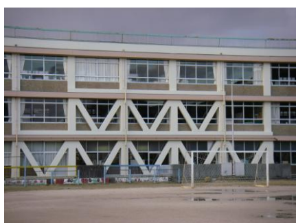
【西益田小学校耐震化事業 (H25 年度)】
