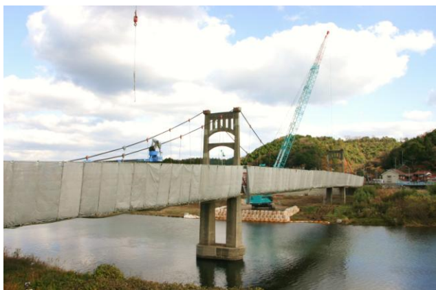
【飯田吊橋修繕状況（H24 年度）】
