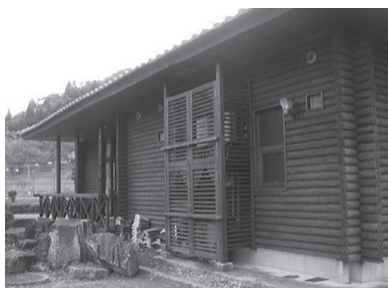
塗装後の匹見中央公園管理棟
