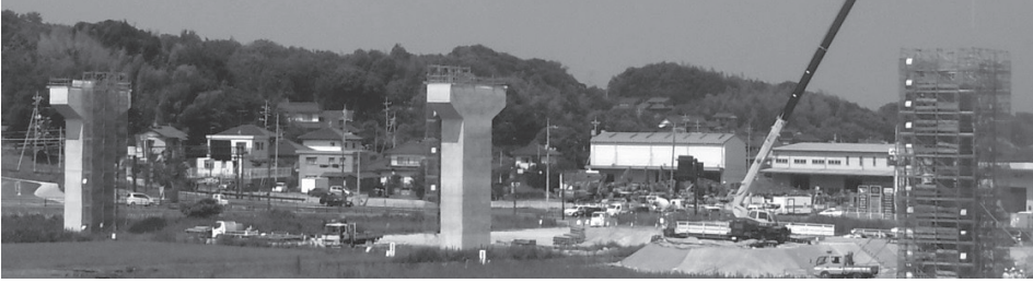
三隅・益田道路 遠田IC付近の状況
