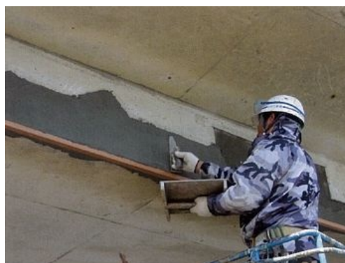
写真 4-3 断面修復状況
