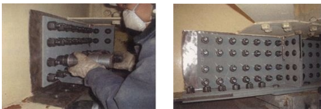
写真 4-1 当て板工実施状況
