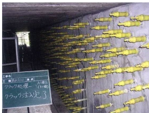
写真 4-2 ひび割れ注入状況
