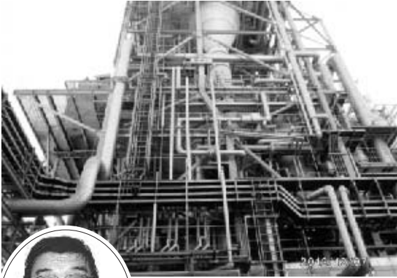
岩国市の木質バイオマス発電所
