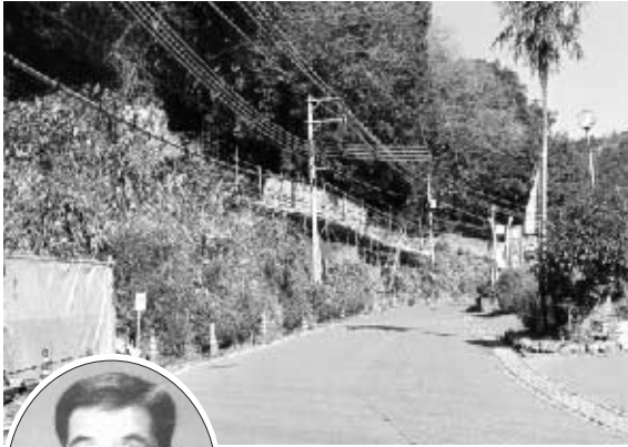
柿木福祉センター前改良工事
