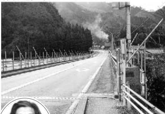
柿木大橋全景
