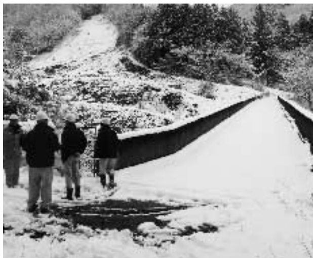
〔蓼野橋剥落防止ネット設置〕
