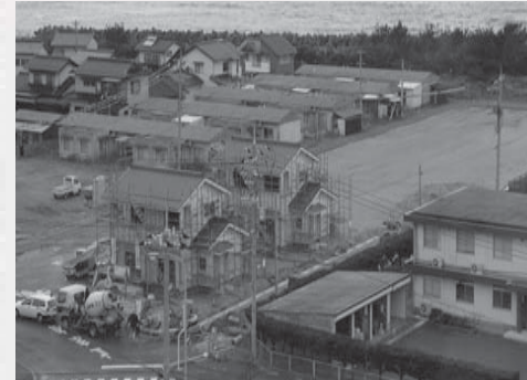
建設が進む医師住宅
