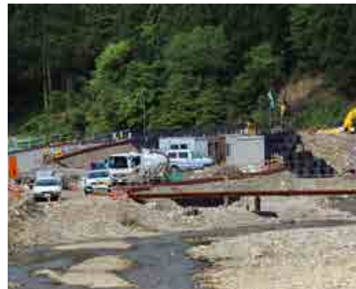
復旧工事が進む名賀地区
