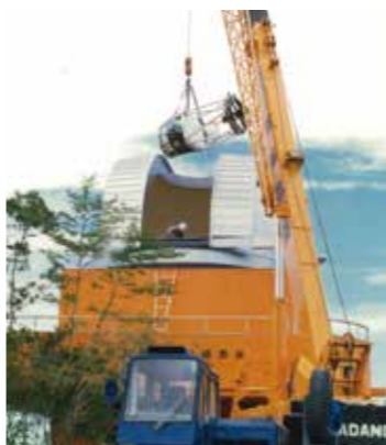
設置されたばかりの望遠鏡（写真上）。その搬入は、私たちが星を観察するドームの間からクレーンを使って行われました。（写真下）
