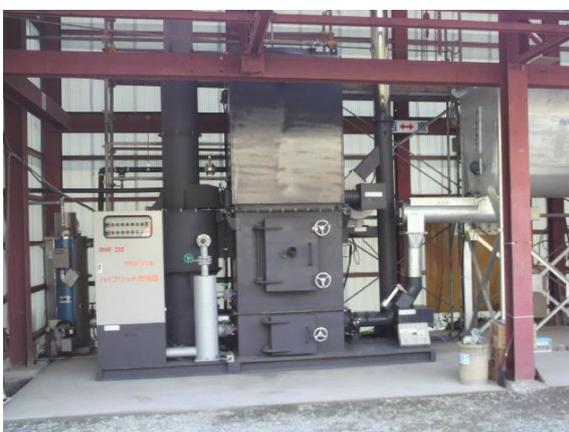
写真9 試験運転中のバイオマスチップボイラー
