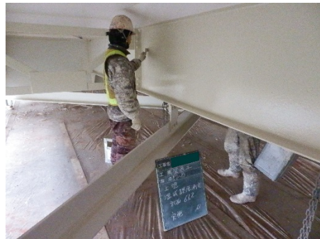
写真 4-1 塗装塗替工
