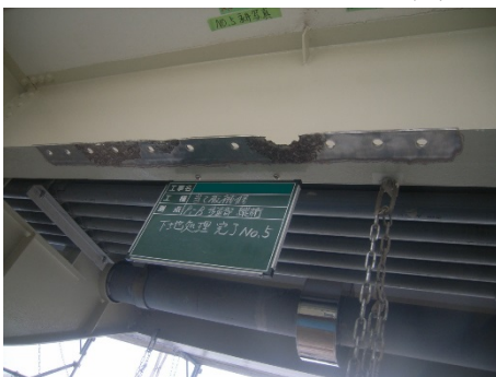
写真 4-2 当て板補強工
