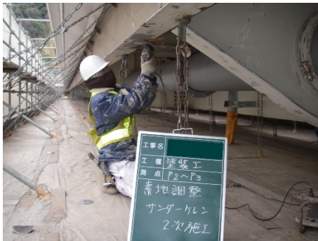
写真 4-1 塗装塗替工
