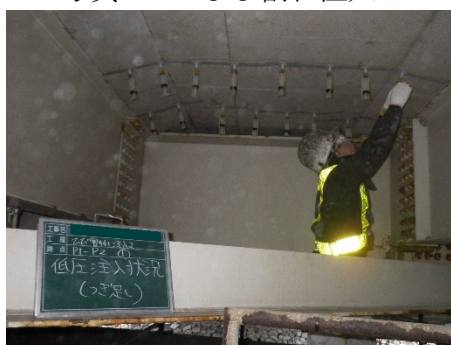
写真 4-4 ひび割れ注入工
