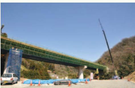
▲建設工事が進む「殿畑東大橋」(湯抱)
