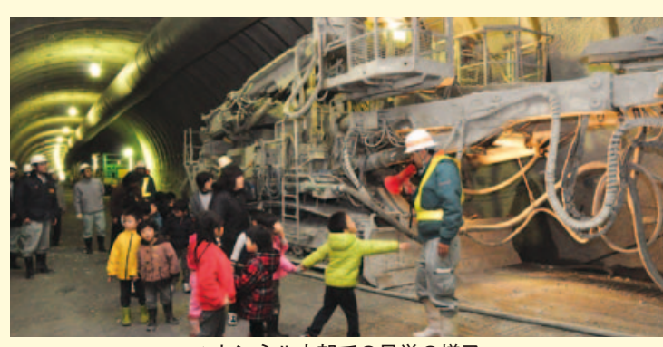
▲トンネル内部での見学の様子
