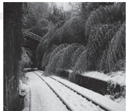
雪が竹に着雪し線路内に竹林が入り込み、線路を塞いだ状態
