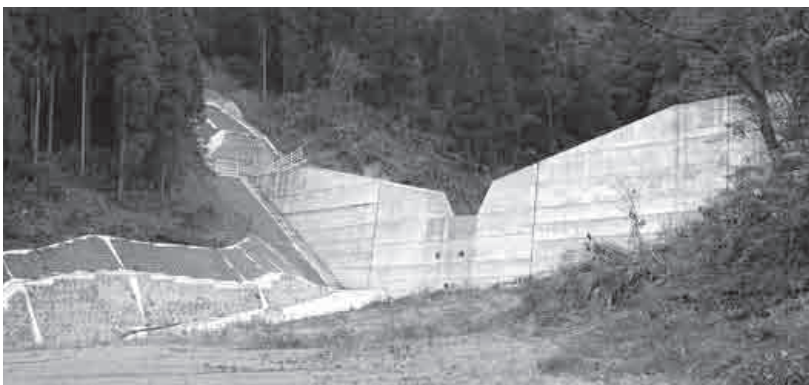
砂防・治山堰堤
