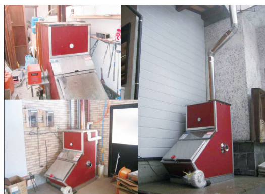
図表IV-4-3 ウッドボイラーの事例
