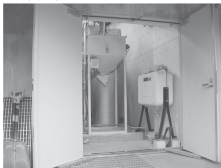
資図表 V-2-12 ボイラー室
