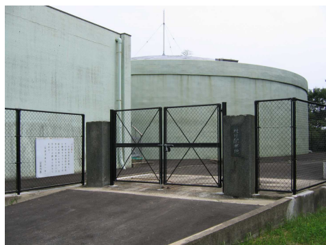
社日配水池（安来市）
