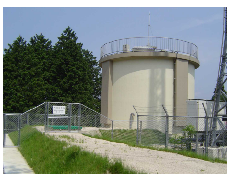
比田 滝谷配水池（広瀬町）
