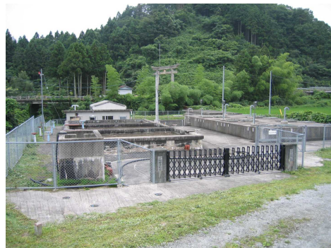
西比田浄水場（広瀬町）
