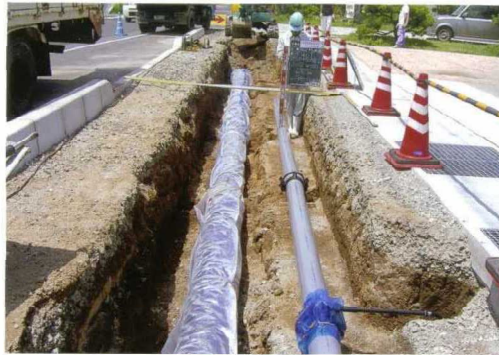
安来港飯島線 道路改良工事（安来市）
