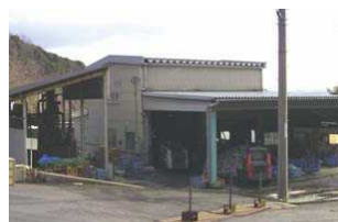
広瀬一般廃棄物最終処分場 不燃物処理施設 埋立終了年度:2021
