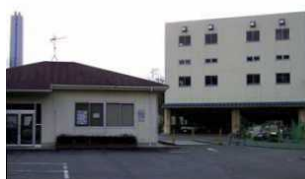
高尾クリーンセンター 粗大ごみ処理施設
