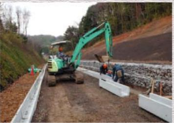
林道開設(側溝据付状況)
