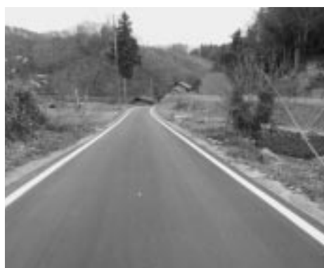
町道恵比線の舗装工事を行いました
