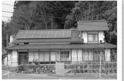
民家を利用したグループホーム
