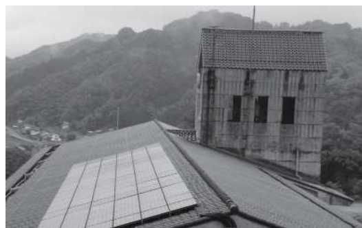
市立学校に設置されている太陽光発電システム
