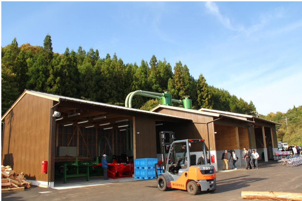
写真：飯南木質バイオマスセンター
