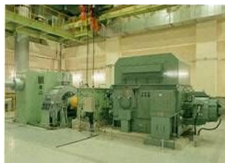
■出雲エネルギーセンター 発電設備（3,000kw）
