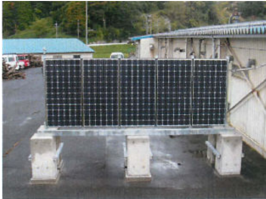
写真1 垂直設置型太陽電池（立上1m）
