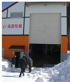
木質バイオマスガス化発電設備
