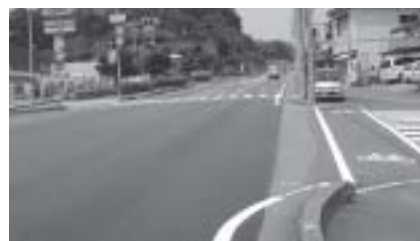
2件の死亡交通事故が発生した長沢町国道9号
