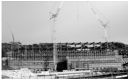
浜田医療センター工事風景（1月上旬現在）
