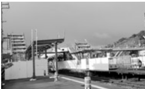
駅舎工事風景（1月上旬現在）
