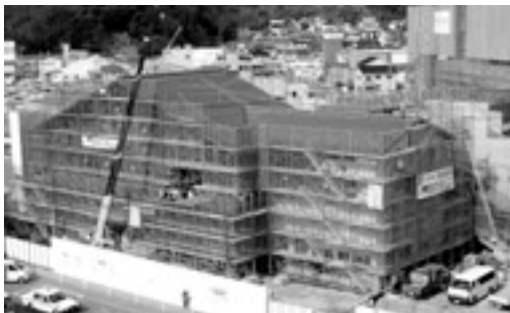
駅舎工事風景（3月上旬現在）
