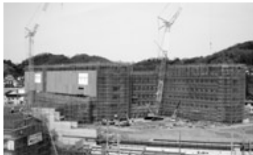
浜田医療センター工事風景（3月上旬現在）
