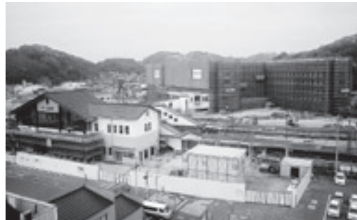
浜田医療センター工事風景 (5月上旬現在)
