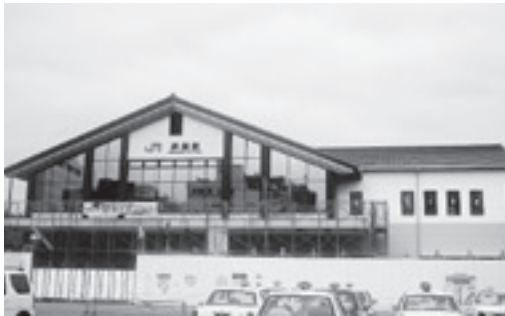
駅舎工事風景 (5月上旬現在)
