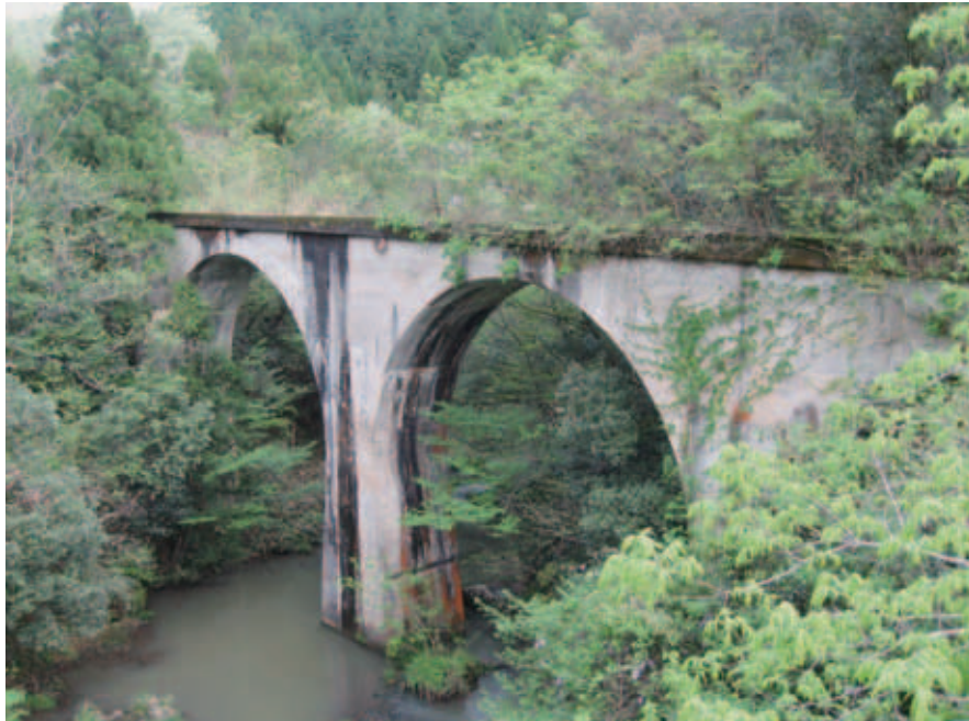
下長屋トンネル西口で新線と並行する旧線のアーチ橋
