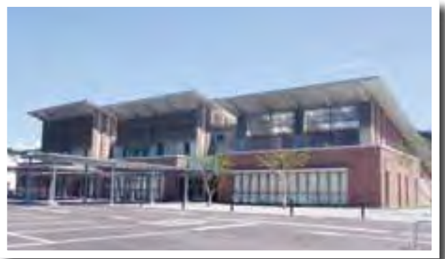
(写真①) 中央図書館が新築オープン
