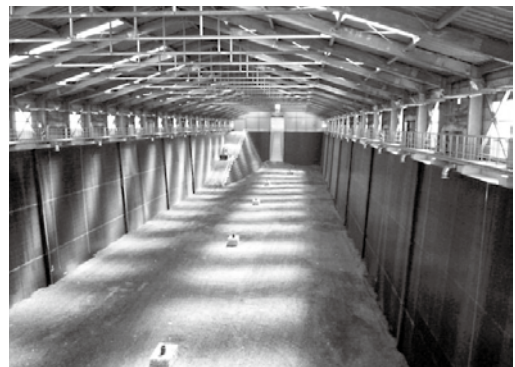
浜田市埋立処分場（最終処分場） (生湯町)
