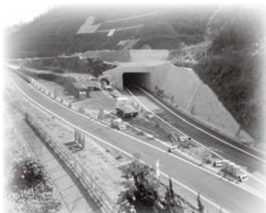
原井インターチェンジ付近（平成26年10月撮影）
