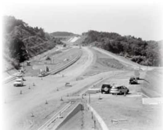
西村インターチェンジ付近（平成26年10月撮影）
