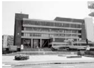
本庁舎耐震改修事業 (事業費5億4,808万円)
