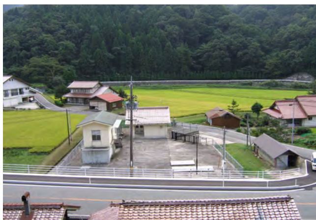
写真 6 長田浄水場 (雲城波佐簡易水道事業)
