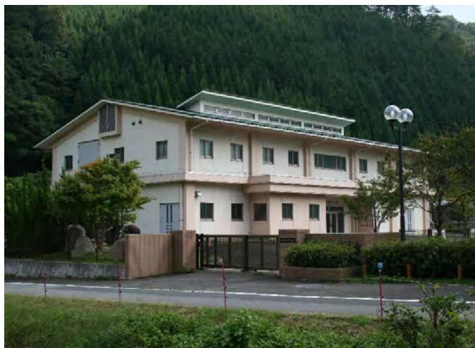
写真 9 都川浄水場（新旭簡易水道事業）
