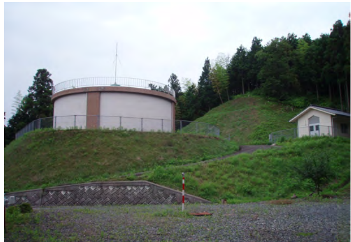
写真 1 5 杜氏が峠配水池（三保簡易水道事業）
