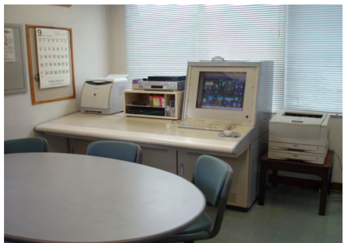
写真 1 6 中央監視システム（三隅支所）
