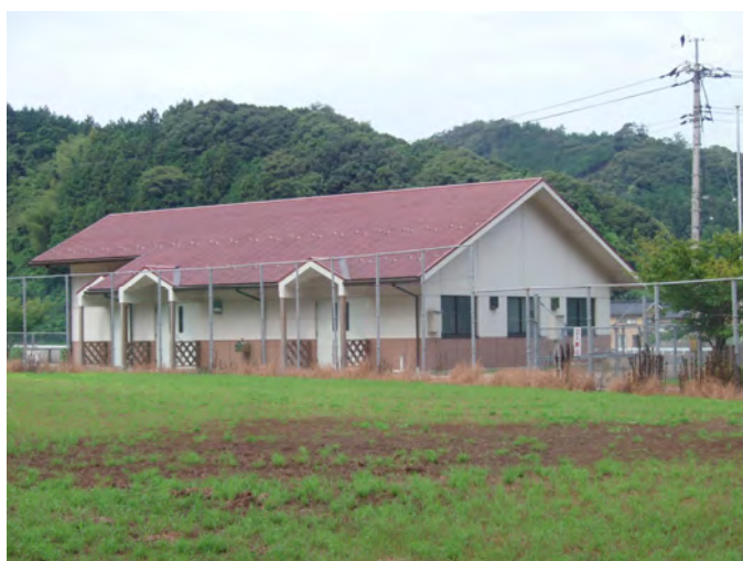
写真14 三保第四浄水場(三保簡易水道事業)
