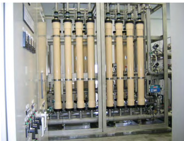
写真 5 膜ろ過装置 (波佐浄水場)
