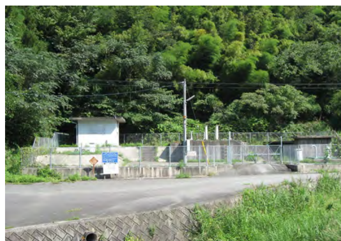
写真13 高内浄水場(弥栄簡易水道事業)
