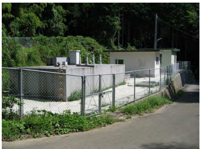
写真11 野坂浄水場（弥栄簡易水道事業）
