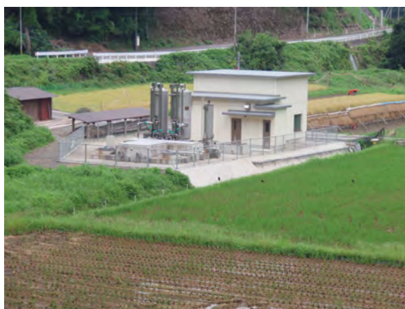
写真 4 河内浄水場(河内簡易水道事業)
