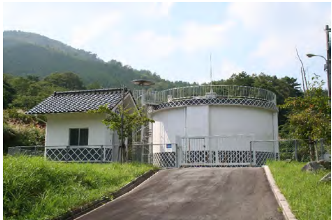
写真 8 坂本峠配水池（新旭簡易水道事業）
