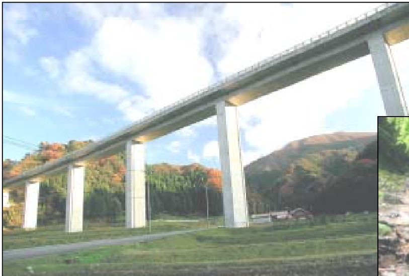
旭町 市木 「早水川橋」
