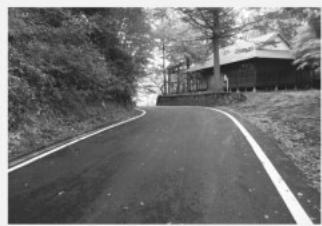
舗装工事を行った町道恵比線
