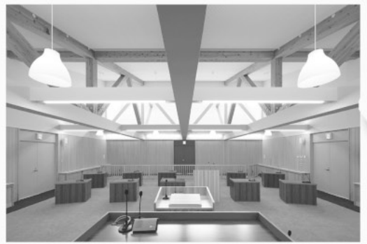
議場入口から見る木造のトラス
