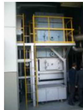
チップボイラーの事例 (滋賀県高島市)
