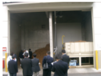
熱供給施設にて
