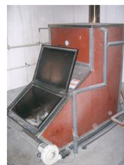
使用されている 薪ボイラー
