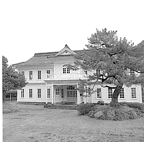
3 周吉外三郡役所（現 隠岐郷土館） （島根県教育委員会提供）
