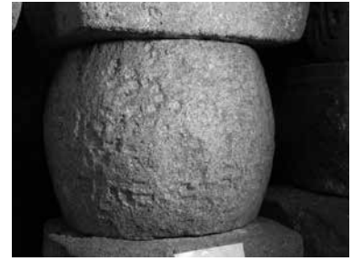
図11 水輪のノミ状工具痕 (岩屋寺石塔群1号窟内五輪塔)
