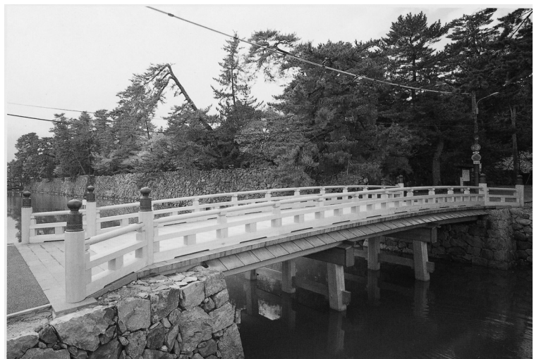
復元された北惣門橋
